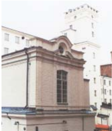
Vanha turbiinirakennus TR1:n kyljessä.
